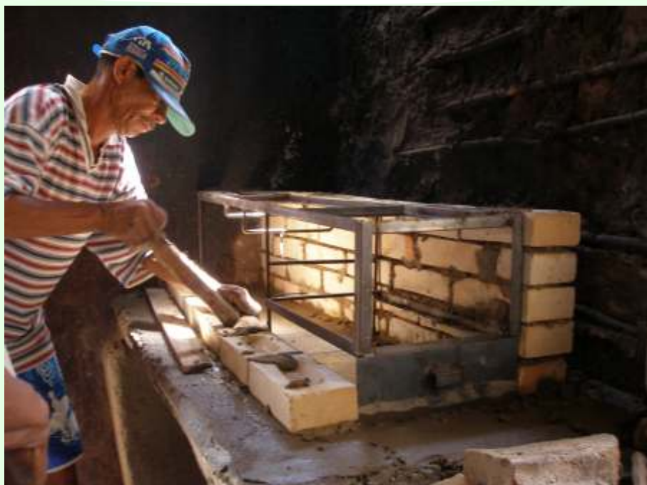
Pedreiro de comunidade rural constrói fogão ecológico: capacitados, trabalhadores locais podem participar de novos projetos de disseminação
