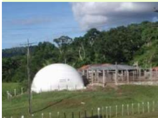
O biodigestor foi instalado junto ao curral
